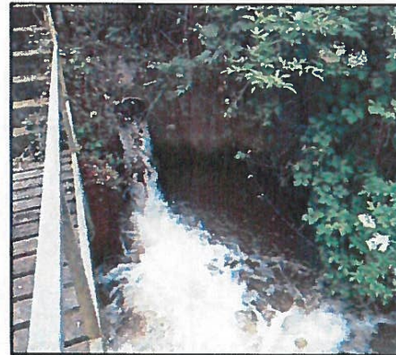
Rejet de la station d'épuration juste en amont de l'ouvrage.
